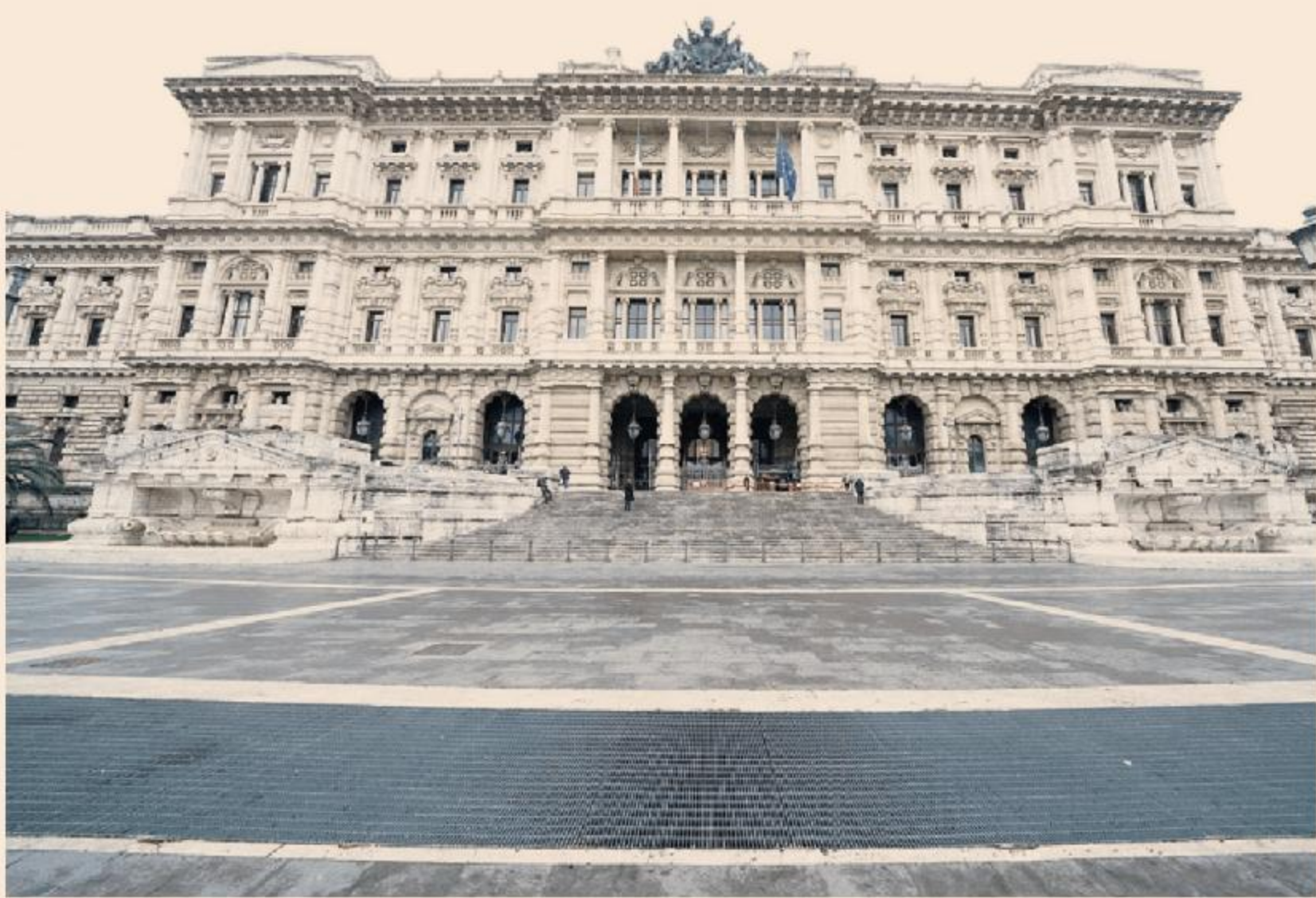
Il Palazzaccio. La sede della Corte di Cassazione in Piazza Cavour a Roma
