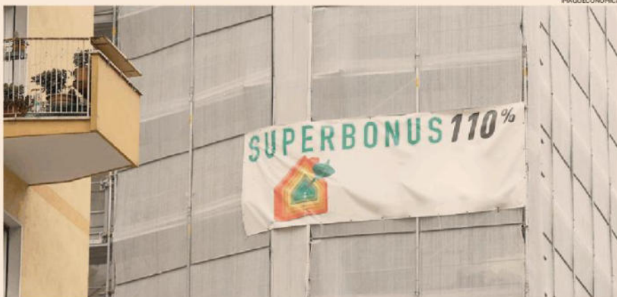
Sorte comune. Da comunicare interventi di recupero edilizio e di riqualificazione energetica su parti comuni di edifici residenziali
